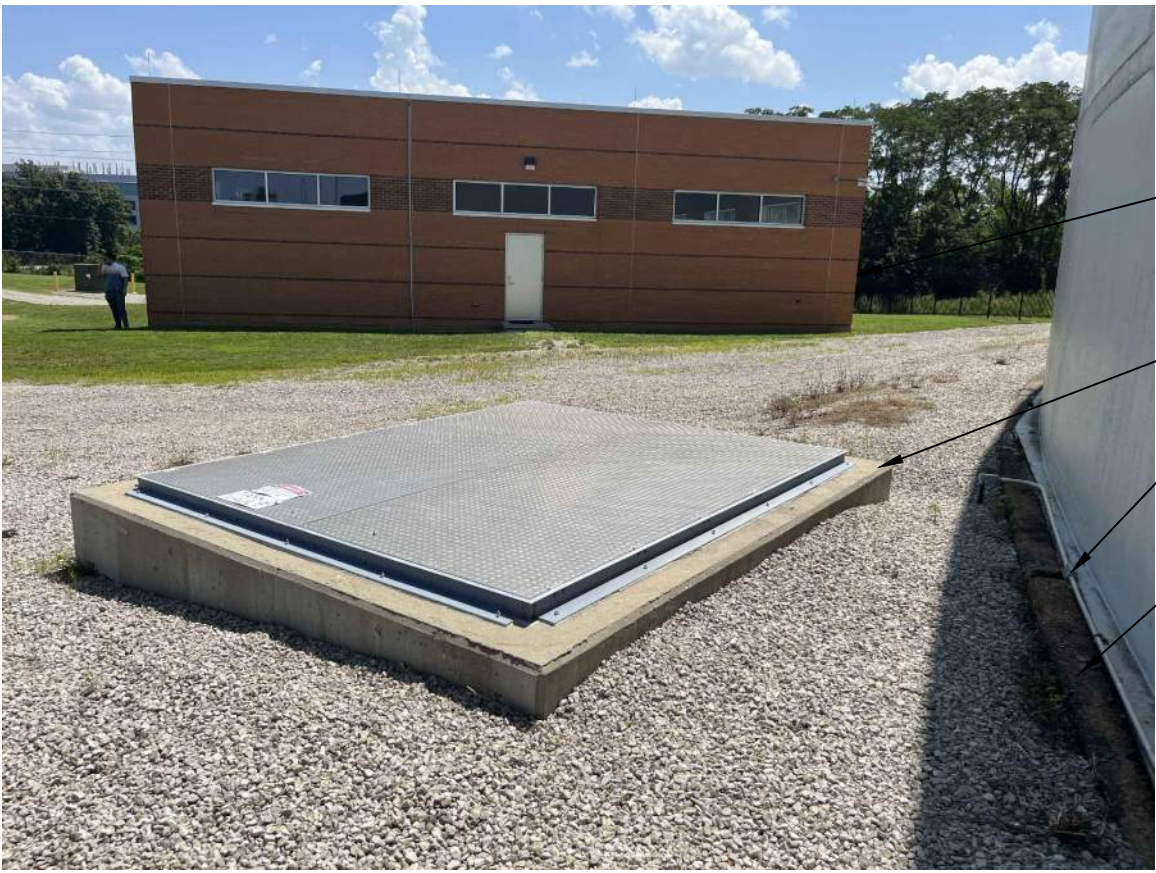
TANK NO. 2 VAULT PHOTO NO. 1 SCALE: N.T.S.
