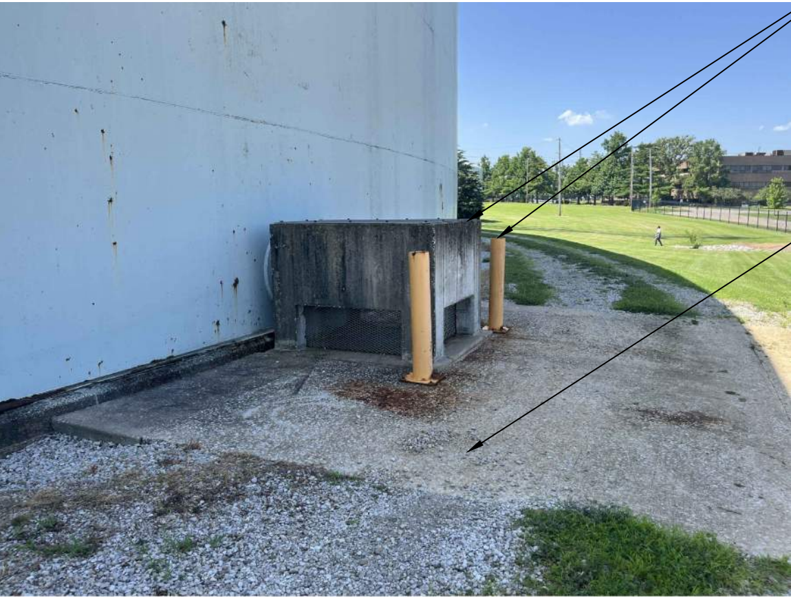
TANK NO. 2 PHOTO 3 SCALE: N.T.S.
