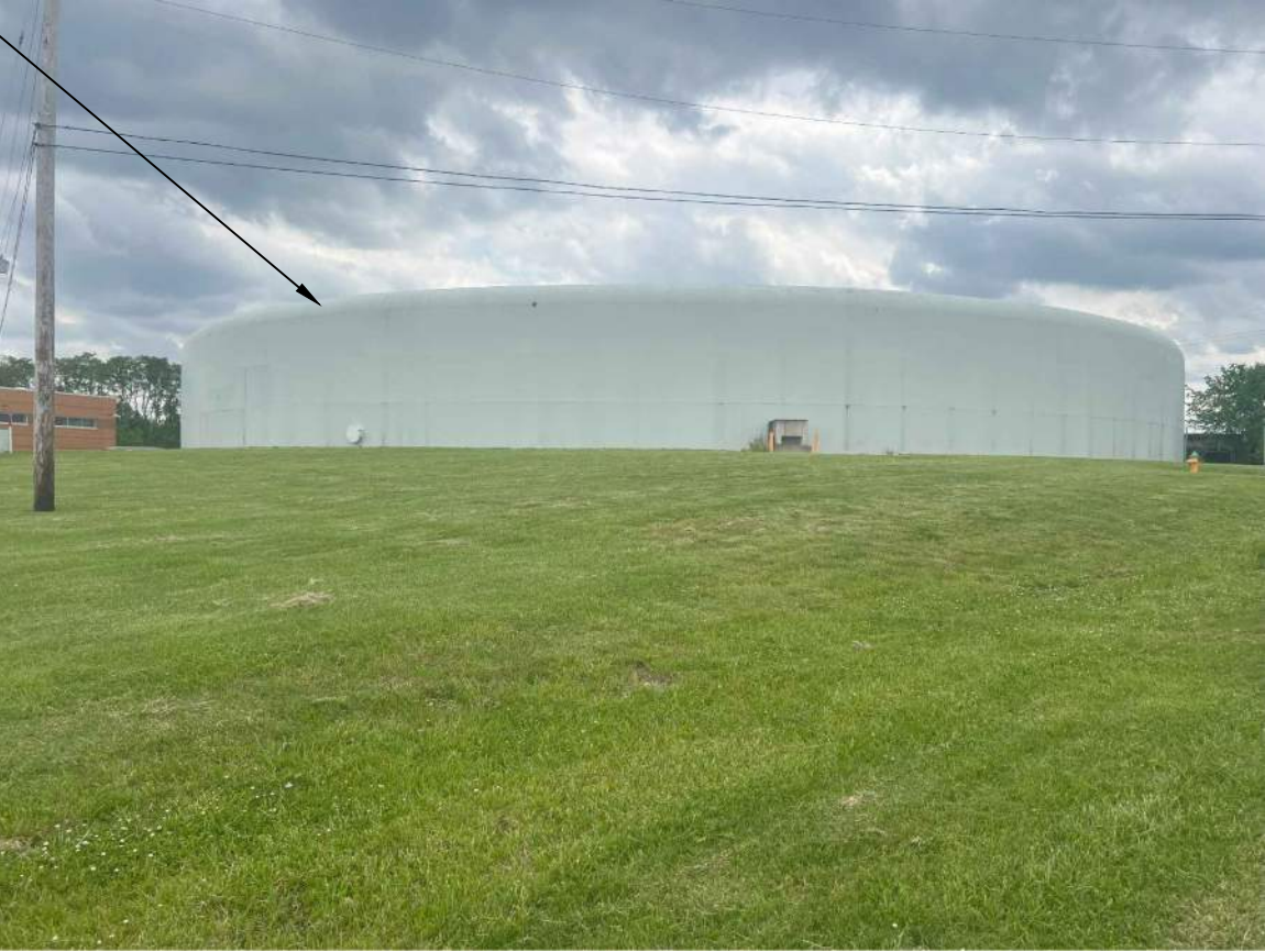
TANK NO. 2 PHOTO 1 SCALE: N.T.S.
