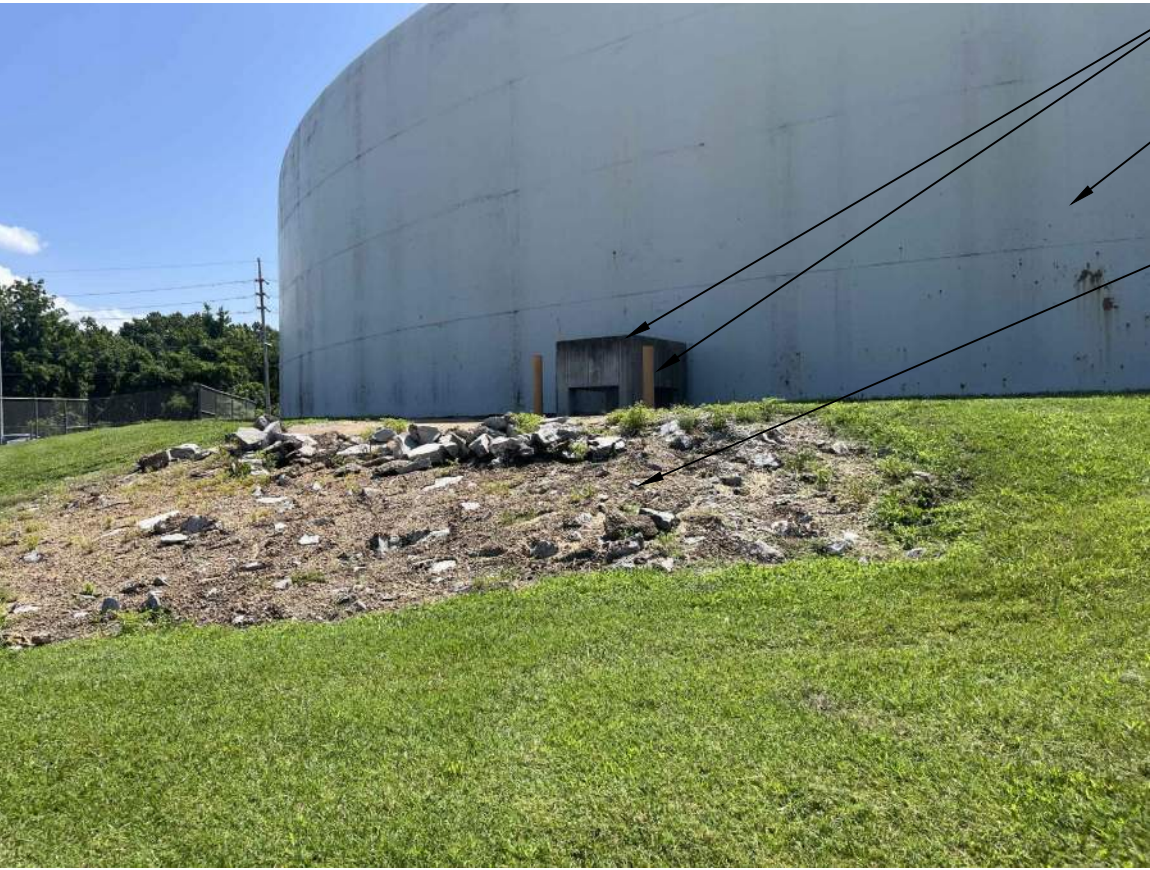
TANK NO. 2 PHOTO 2 SCALE: N.T.S.
